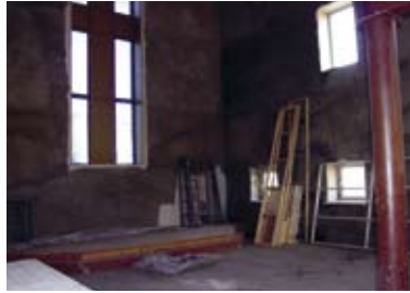
Kirche in Krasnoturinsk im Rohbau stagniert, weil die EKD kein Geld mehr herausrückt
